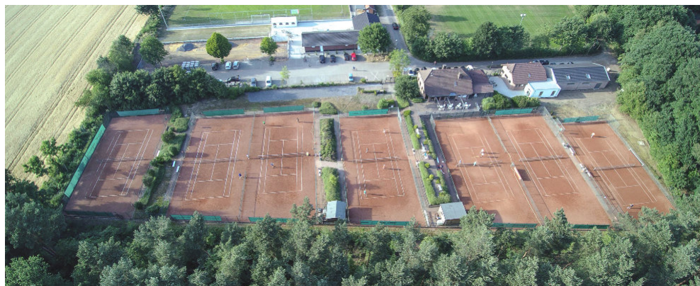
TV Rhede Vereinsanlage mit Vereinsheim, Tennisplätzen, Bouleanlage und Fitnesshalle
